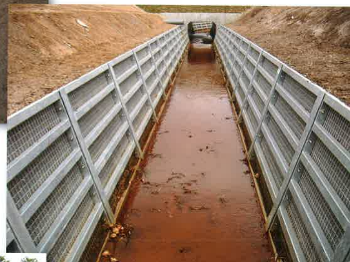
鋼製水路3分壁その1 H1.5×B1.5
