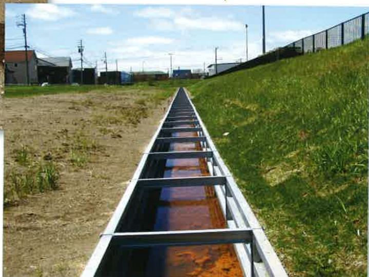
鋼製水路その1 H1.0×B1.0切梁有
