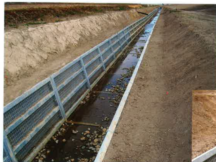
鋼製水路3分壁その1 H1.0×B1.0
