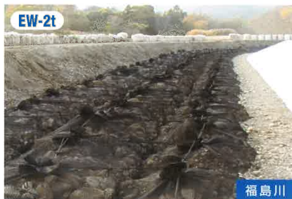
根固め工【函館建設管理部 知内事業所】
