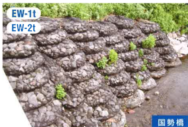
法面保護工【稚内建設管理部 利尻出張所】
