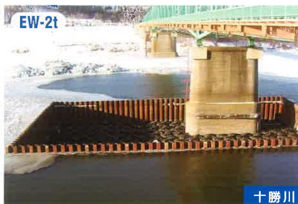
橋脚保護工【帯広建設管理部 浦幌出張所】
