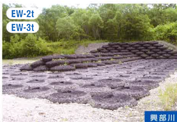
水制工【網走建設管理部 興部出張所】
