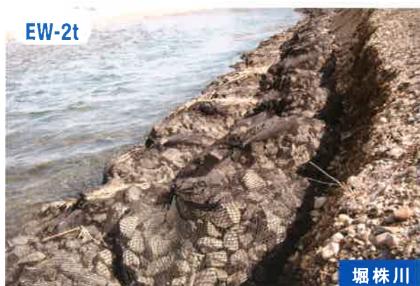
根固め工【小樽建設管理部 真狩出張所】
