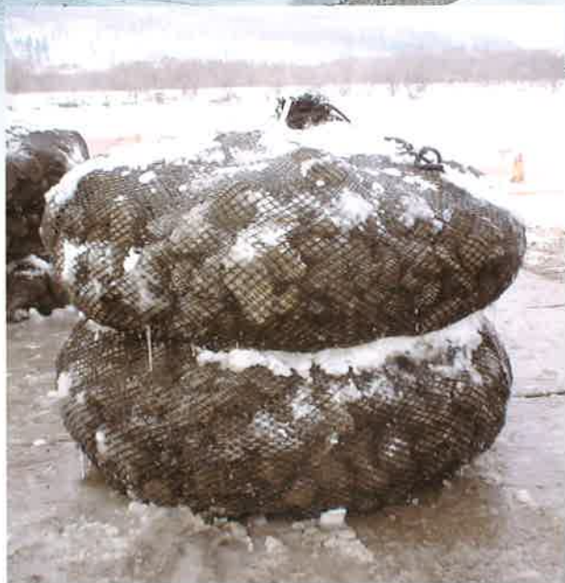
仮置き状況(冬季施工時)
